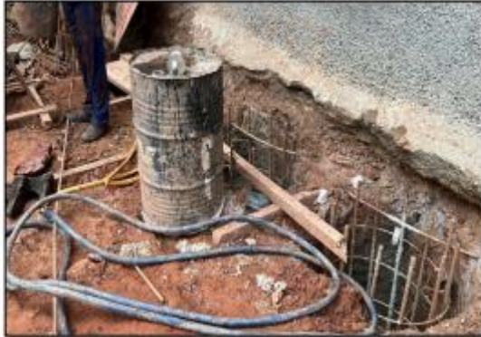
Escavação de tubulões
