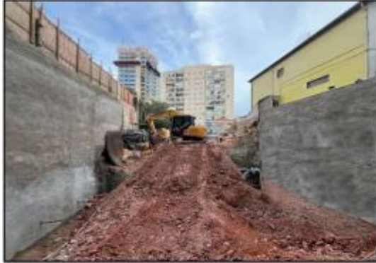
Escavação e contenção do solo
