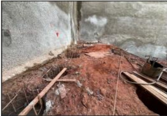
Concretagem de tubulões
