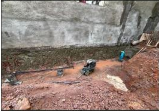
Contenção do solo
