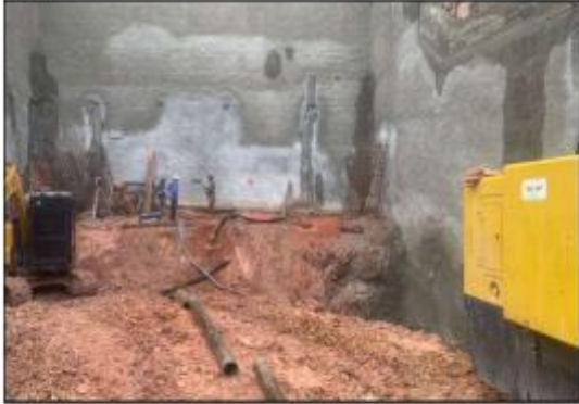
Vista geral da obra
