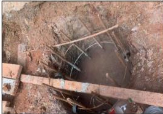
Concretagem de tubulões
